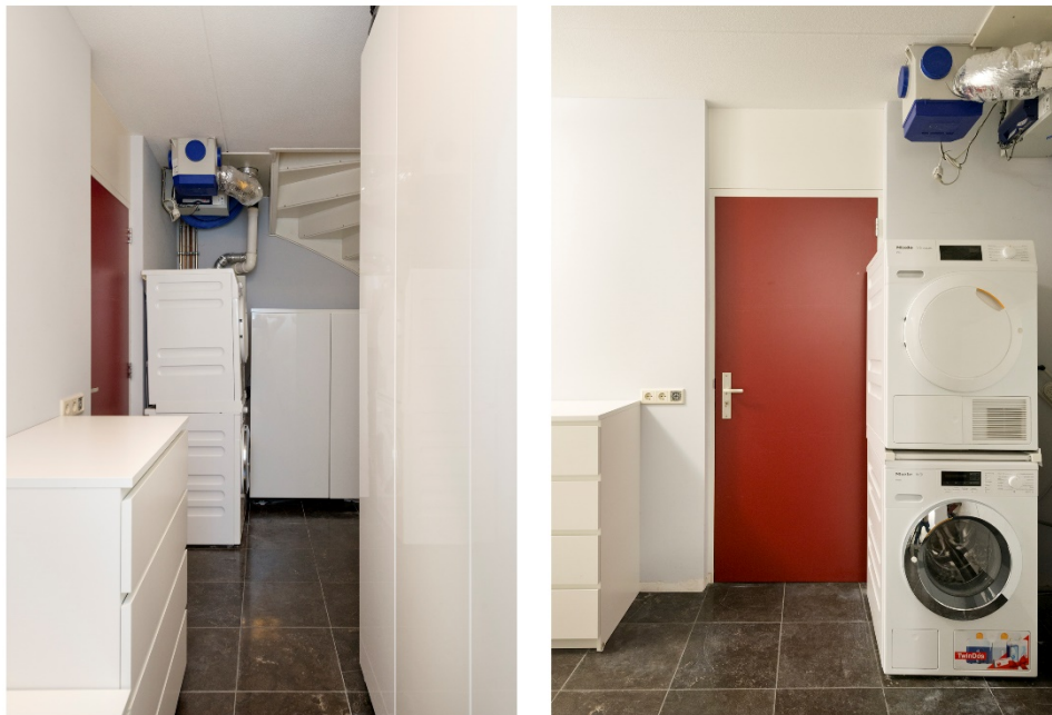
Wasruimte in het souterrain
