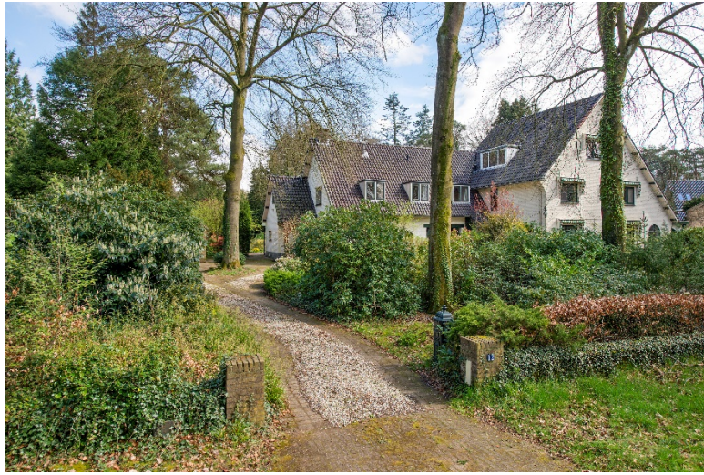
Kabeljauwallee te Doorwerth
