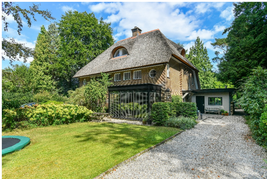
Kabeljauwallee 10 te Doorwerth
