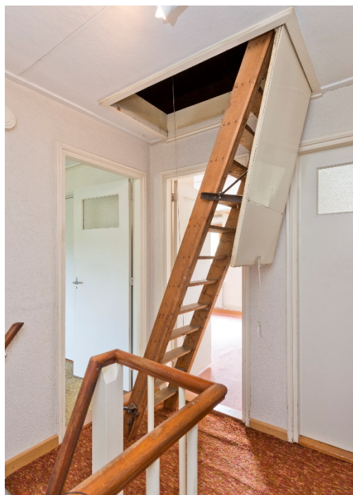
Overloop met vlizotrap naar zolder
