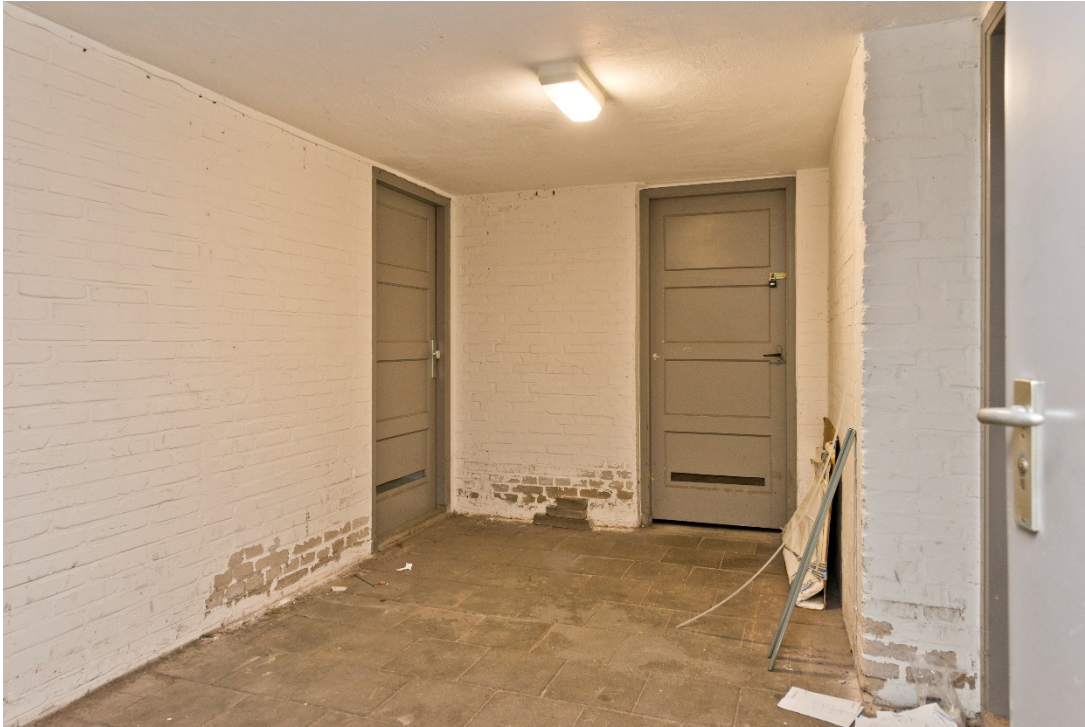
Berging in onderbouw
