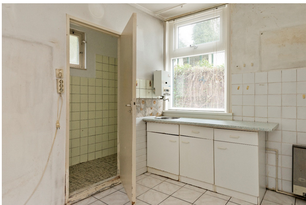
Keuken met toegang badkamer
