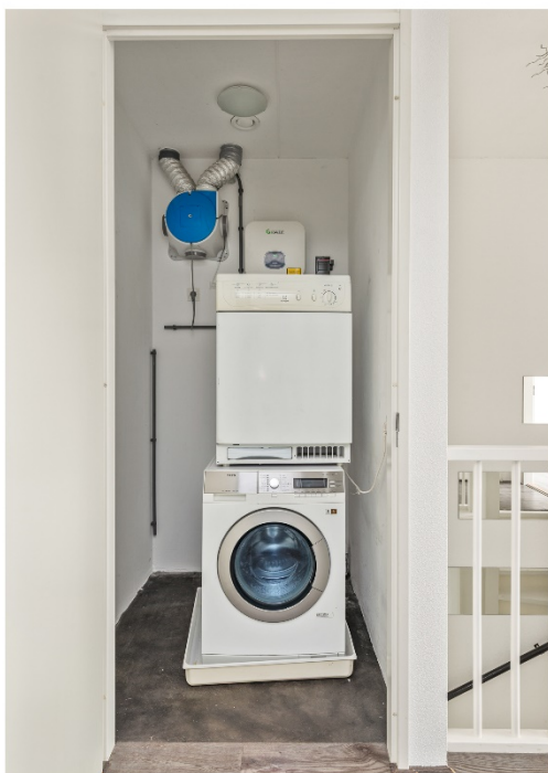
Wasruimte op overloop
