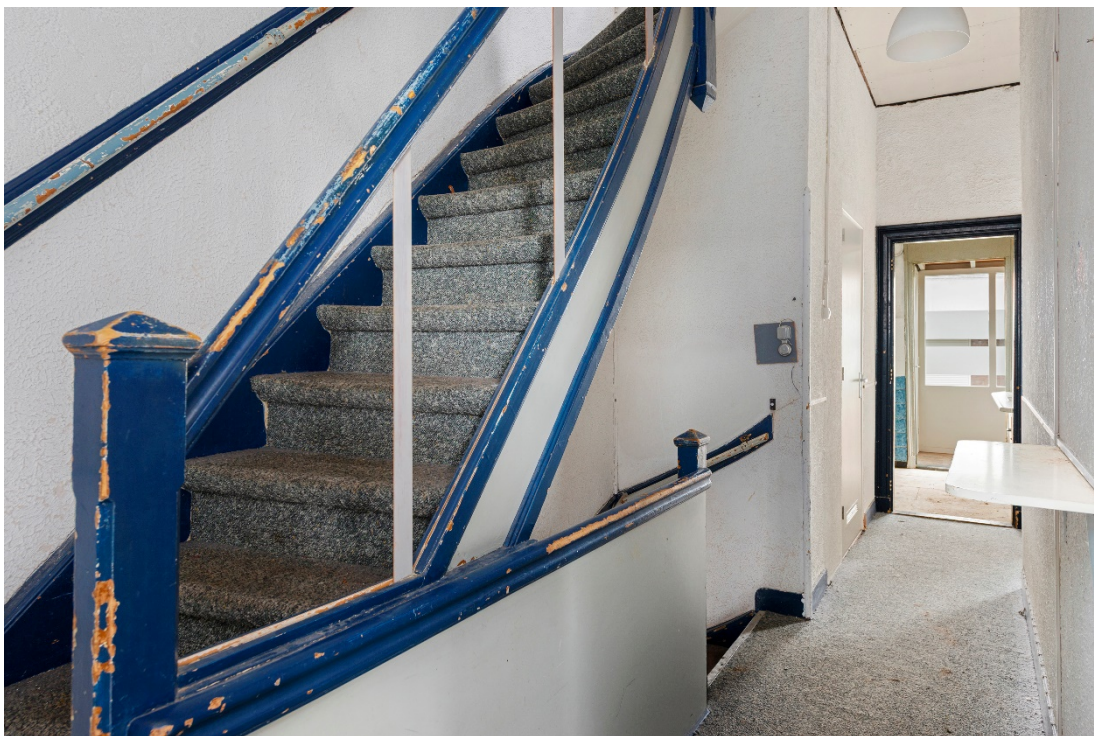
Trap naar bovenverdieping
