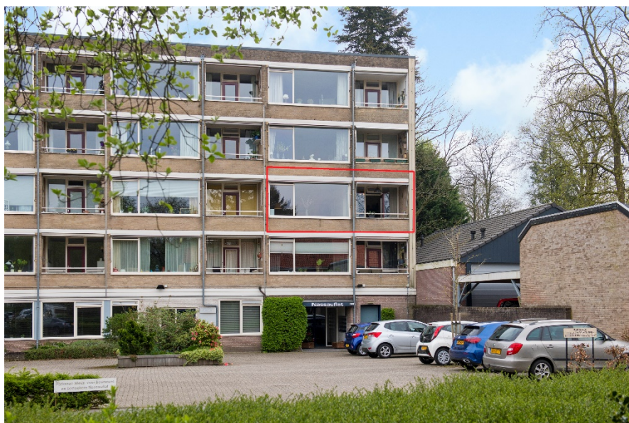
Steijnweg 7 F te Oosterbeek
