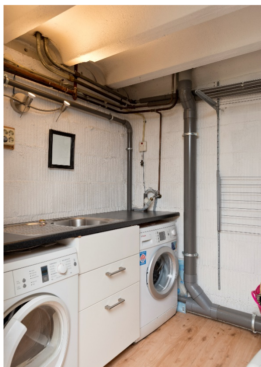
Berging/wasruimte in het souterrain
