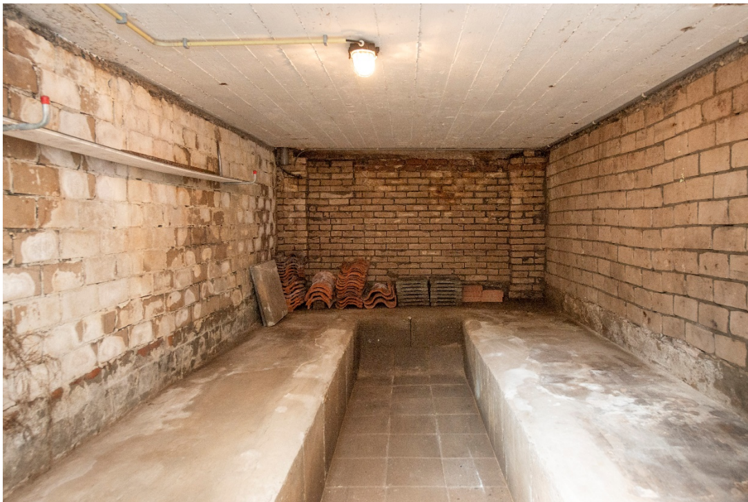
Kelder onder garage
