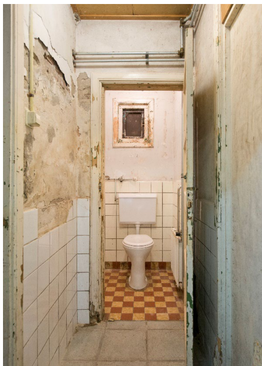
Hal met toilet
