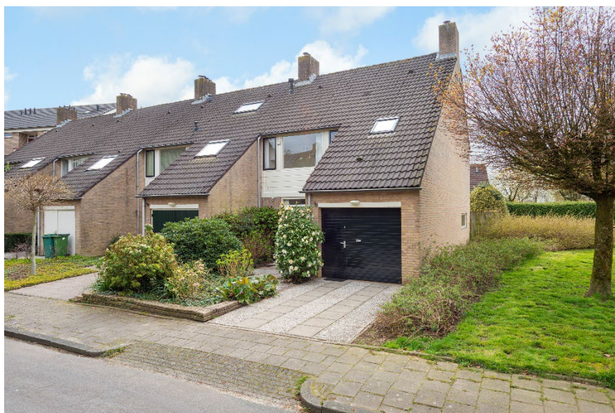
Margrietstraat 32 te Oosterbeek
