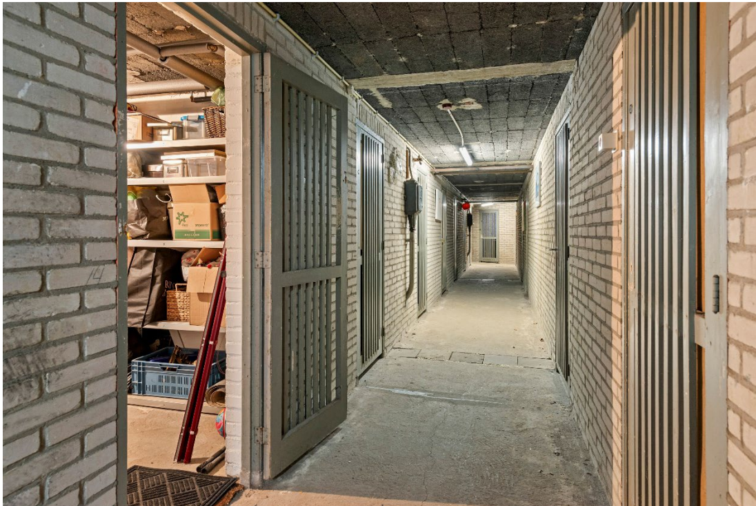
Berging in onderbouw
