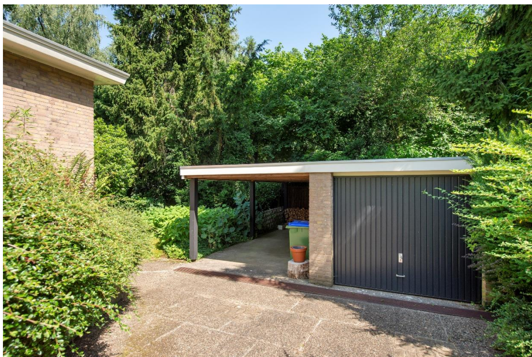
Garage en overkapping
