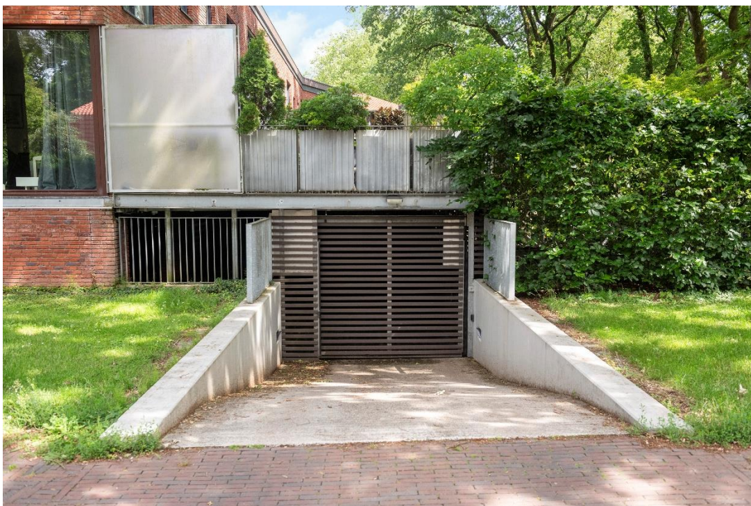
Toegang tot parkeergarage
